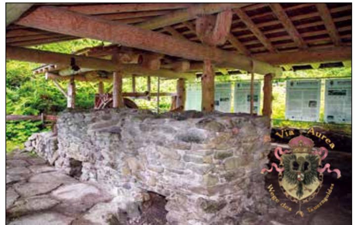
Die drei neu restaurierten Öfen
