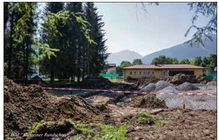
Derzeit noch Baustelle für die neuen Padel-Tennisplätze
